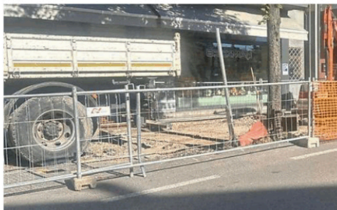
I cantieri sospesi in via Matteotti, a Portogruaro
