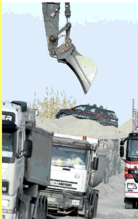
PORTOGUARO I lavori per costruire la terza corsia dell'autostrada 4, uno dei temi più seguiti dalla Fondazione Think Tank
