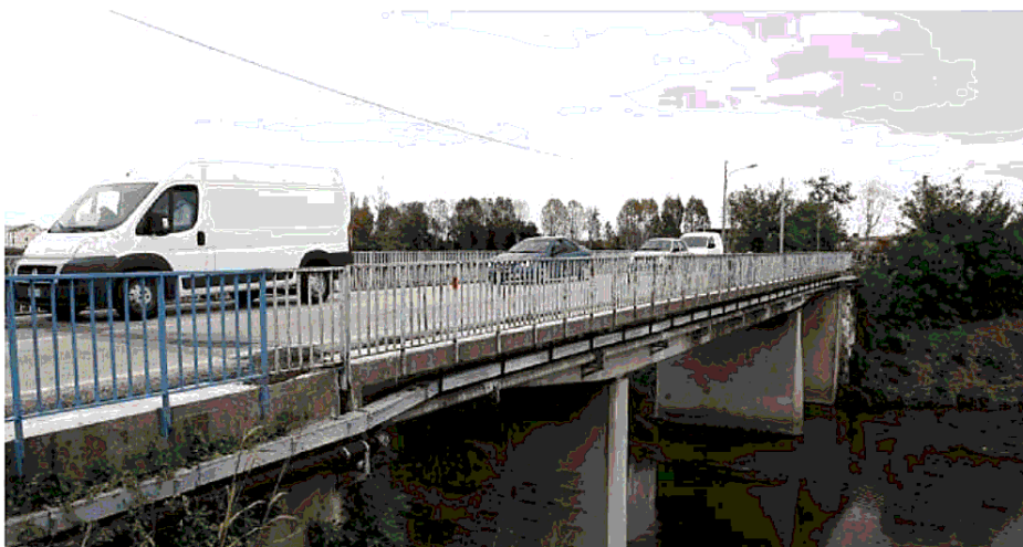
Il vecchio ponte sarà demolito Per realizzare il nuovo serviranno circa 9 mesi: i lavori inizieranno a dicembre
