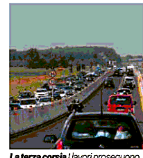
La terza corsia | lavori proseguono
