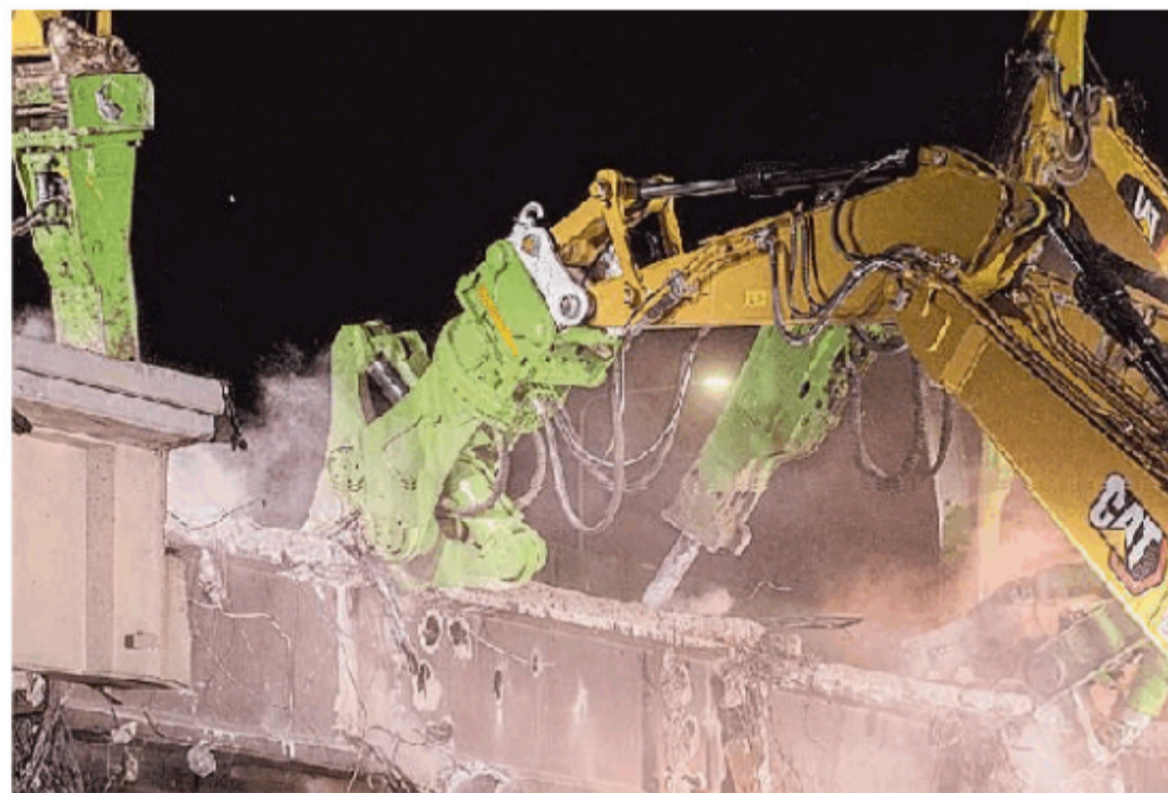
Le ruspe all'opera demoliscono il cavalcavia
