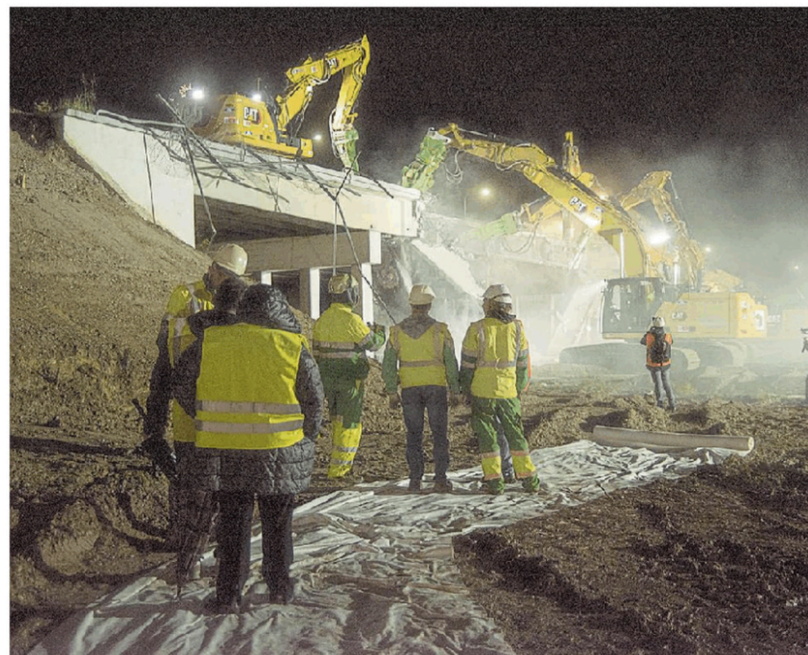
Un altro scatto delle operazioni di abbattimento di sabato sera
