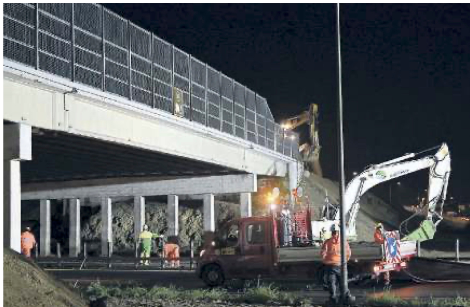
SPETTACOLARE La demolizione del vecchio cavalcavia sull'A4
