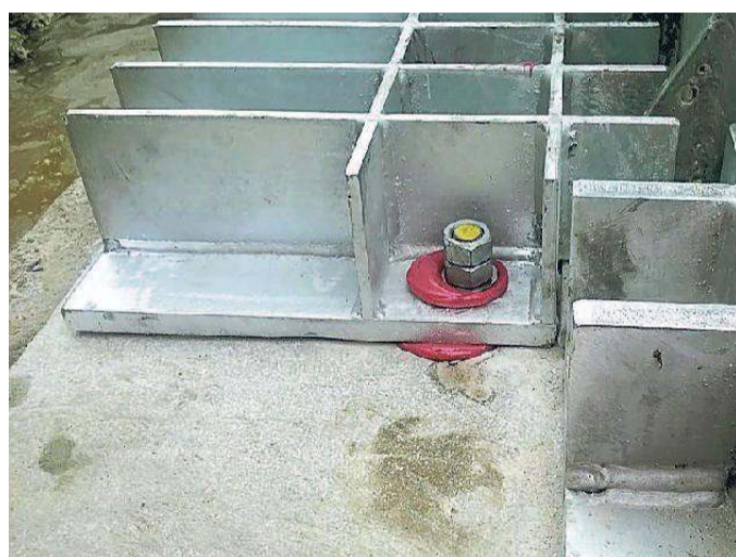
Le nuove fondazioni del portale sul Ponte della Libertà
