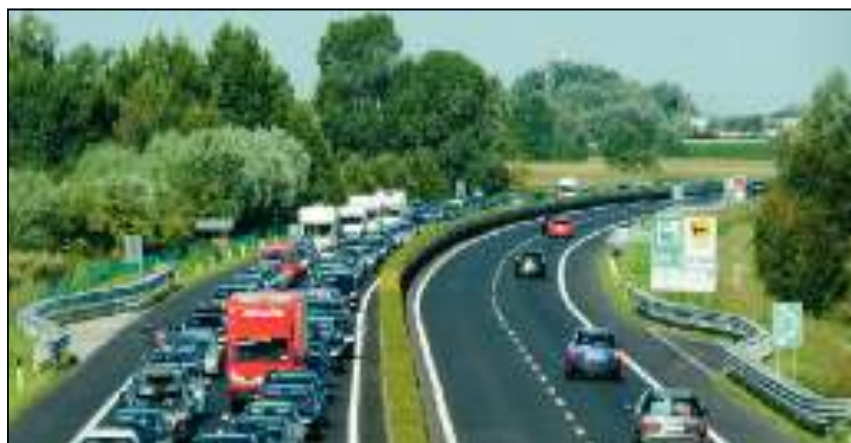
AUTOSTRADA A4 Traffico congestionato anche dal flusso turistico
